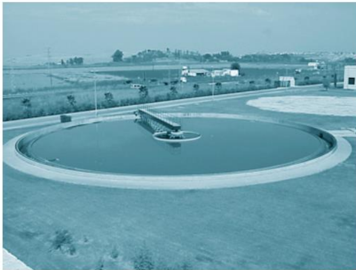
Figura 10 – Decantador primario (CENTA, 2008)
