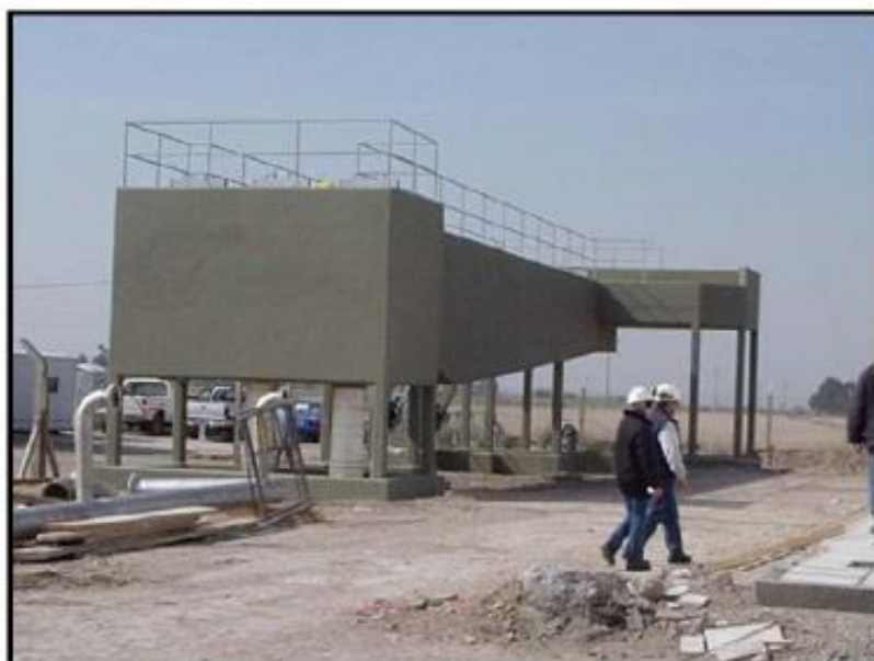
Figura 9 – Vista de un desarenador
