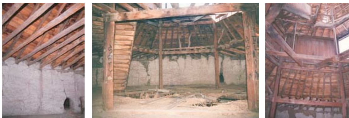
Fig. 10 Imágenes del envigado del torreón en 3er. y 4 to. Nivel, actualmente desaparecido.
